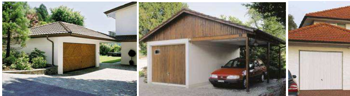
Séparés du bâti principal, ils en gardent cependant les caractéristiques de matières et de couleurs
